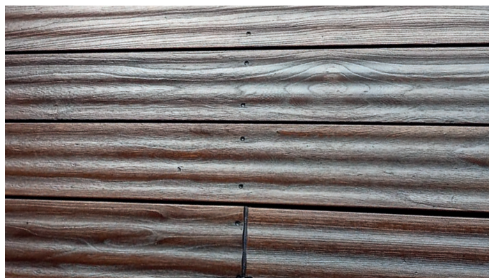
Renovovaná terasa z termo-jaseňa po úprave s DeckFinish Color tmavohnedým.
